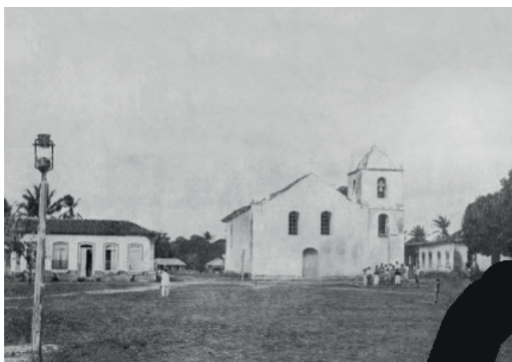
Figura 4 – Área onde se localizava a Igreja de São José, 1901. Fonte: Álbum do estado do Pará. (Relatório do Governador Augusto Montenegro, 1901).
