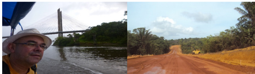
Figura 3 e 4 - Ponte Binacional e BR 156. Fonte: Tostes.
