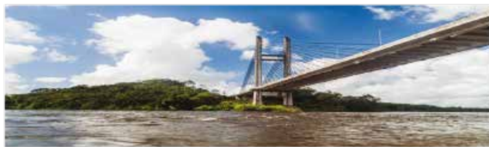
Figura 2 - Ponte Binacional. Fonte: PDP de Oiapoque.
